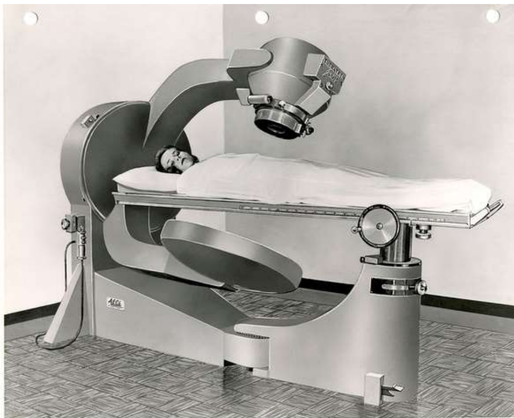
Fig. 6. El Theratron Junior (AECL) fue el primer modelo de unidad de teleterapia con ^{60}\text{Co} instalado en Barcelona en dos clínicas privadas: Pujol Brull (Dr. De Caralt) y Corachan (Dres. Subías y Farrerons)
