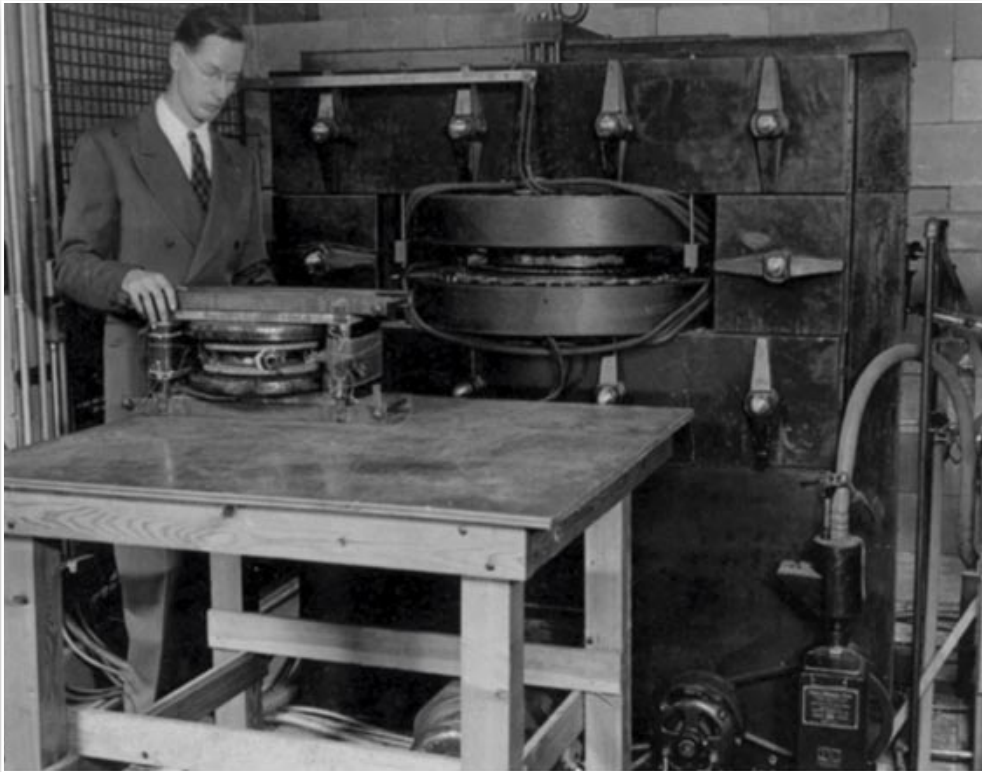
Fig. 3. El Pr. Donald Kerst muestra el primer betatron, de pequeño tamaño, construido por él en 1940 en el laboratorio de la Universidad de Illinois. A su lado izquierdo se muestra un betatron más potente construido bajo su dirección por la firma Allis Chalmers Company, de Illinois (USA). Este primer betatron tenía como finalidad el análisis de defectos ocultos o grietas en metales dedicados a armamento para la II Guerra Mundial.
