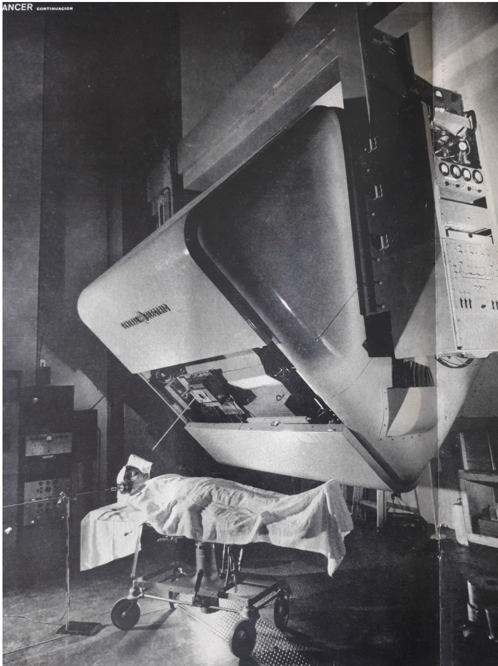
Fig. 6. Sincrotron de 6MV (General Electric) de la Universidad de California con una paciente en tratamiento. Life, 1958.
