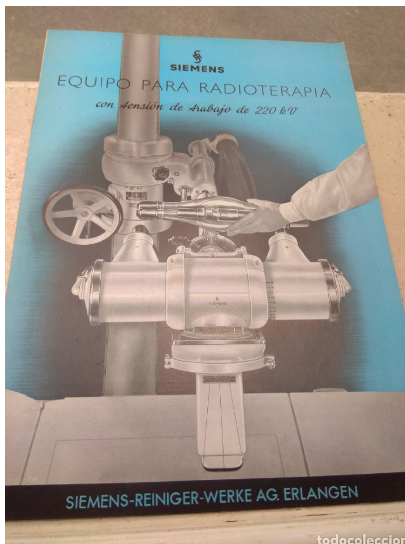
Fig. 16. Aparato de radioterapia de 220kV modelo Stabilipan de Siemens-Reiniger. El tubo va montado en un estativo de columna y dispone de un brazo que le permite un giro angular. El juego de colimadores es rectangular y el que muestra la imagen parece ser de unos 10cm. Estos aparatos trabajaban a una distancia foco-piel (DFP) de 40cm. En la portada del folleto se observa superpuesto al aparato el tubo de RX soportado por la mano del técnico. Ignoramos la fecha, pero probablemente sea de finales de los años 50 del siglo pasado. Se halla a la venta en Todo Colección por 35 euros.
